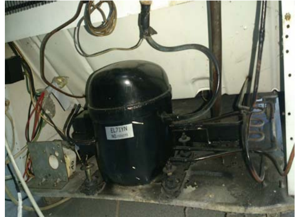
圖 5-11 降溫裝置(壓縮機) 當壓縮機啟動後,便會促使冷媒運作,以達到降溫效果
