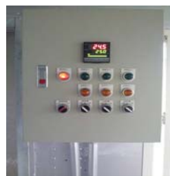
圖 6 製冷壓縮機模組
