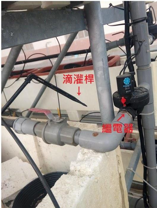
圖 4. 溫網室內繼電器控制與滴灌桿之照片
