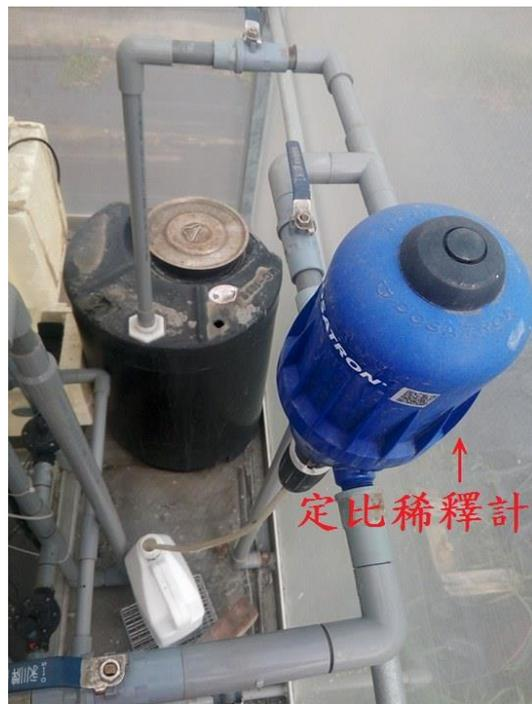
圖 3. 溫網室內定比稀釋計與管路之照片
