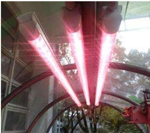
圖 7 補光系統(燈管)設置之狀況
